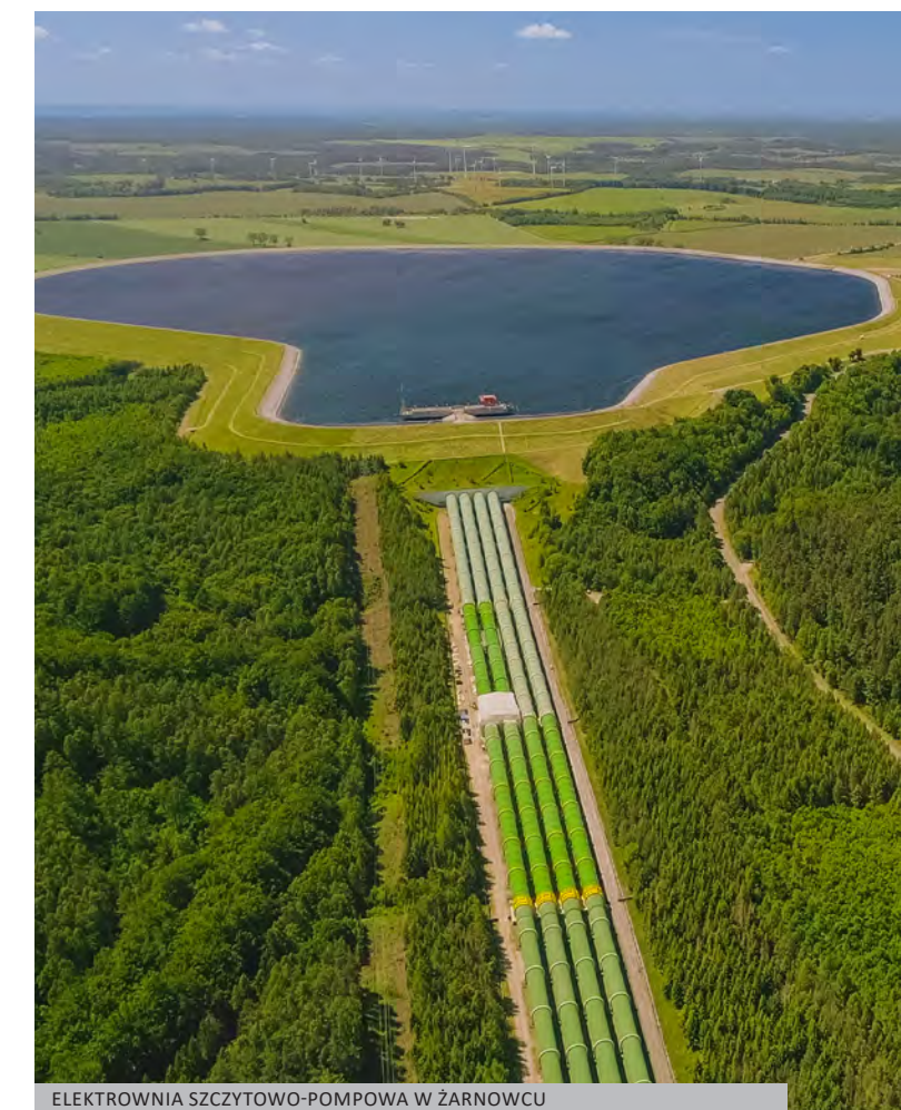
ELEKTROWNIA SZCZYTOWO-POMPOWA W ŻARNOWCU
