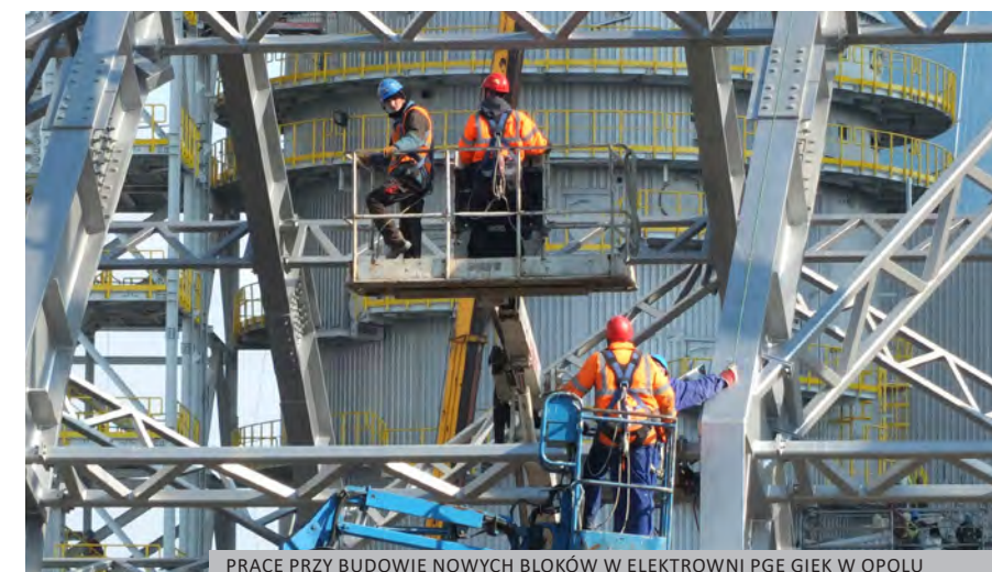
PRACE PRZY BUDOWIE NOWYCH BLOKÓW W ELEKTROWNI PGE GIEK W OPOLU
